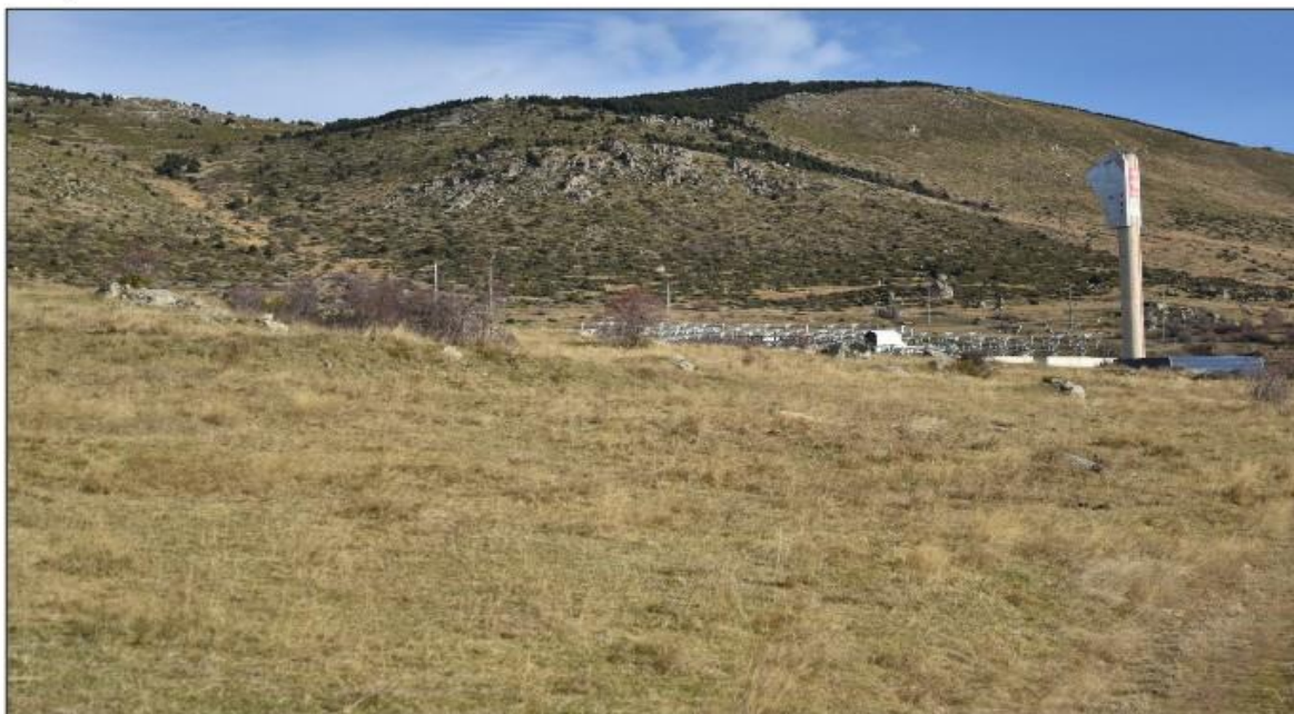
Photographie du site de projet depuis le GR
