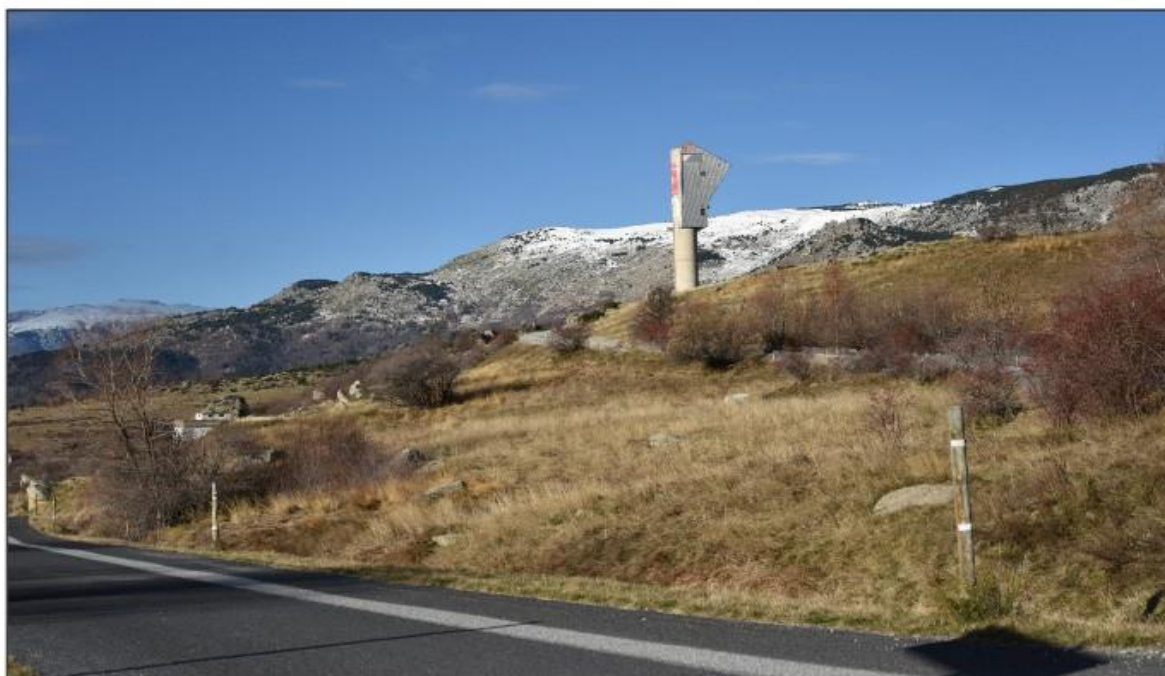
Photographie du site de projet depuis la RD618B entre le village de vacances EPAF et le Mas Vilalta
